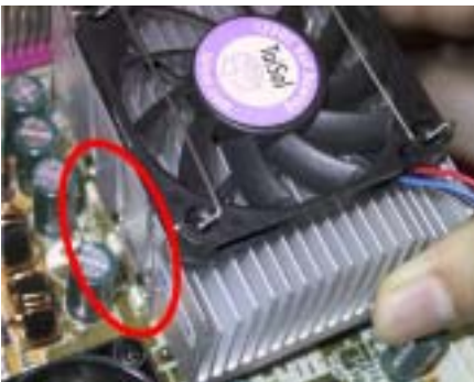
Abb. 4. Installation des Kühlkörpers
